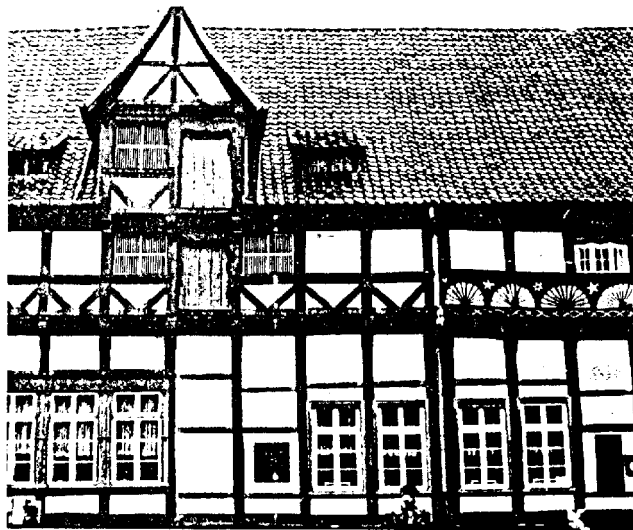
Fig. 6.23 Edificio en Magdeburg con estructura de madera
