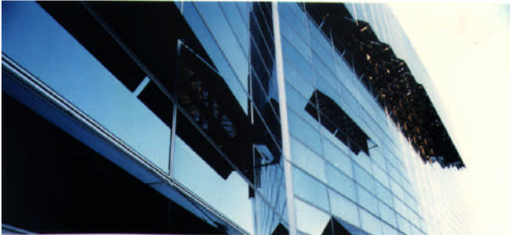
Fig.10.27 Fachada de edificio con poca textura
