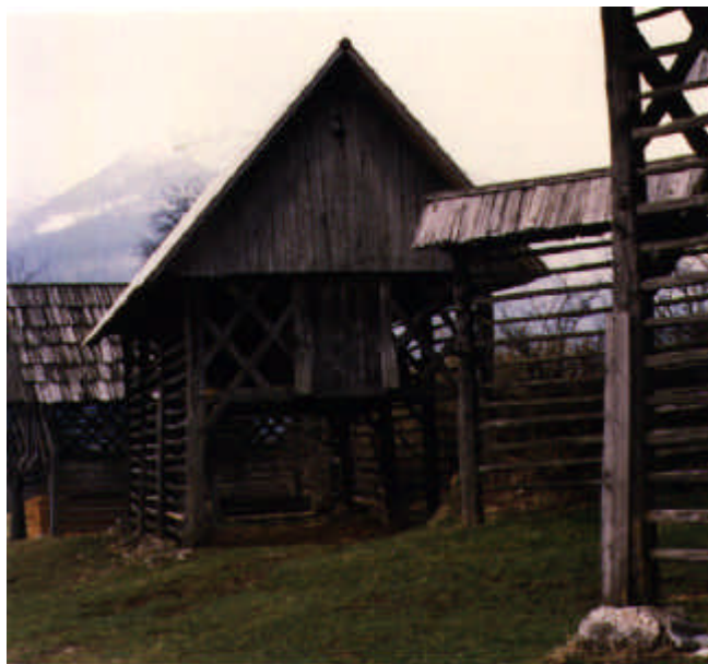
Fig.10.19 Edificio muy permeable al paso del aire
