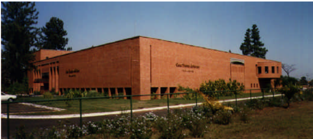
Fig.10.11 Ejemplo de edificio muy asentado
