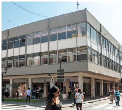
Conj. Habitacional La Muralla
