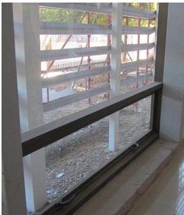
Figura 4.12. Aberturas superiores e inferiores del espacio atrio, edificio Contraloría de la Araucanía, Temuco (zona 7 SI)
