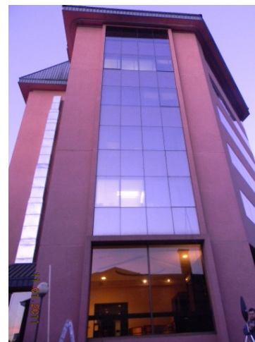
Figura 2.59. Figura 2. 1: Edificio Secretaría Regional Ministerial de Obras Públicas Los Lagos, Puerto Montt.
