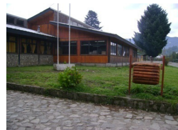
Figura 8.58. Acceso a Escuela, parte antigua habilitada, Curarrehue.
