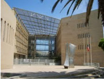
Figura 4. Edificio Secretaría Regional Ministerial de Obras Públicas, Copiapó, Región de Atacama. Sin EE.
