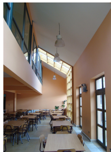
Figura 3.7. Captación solar directa en casino Escuela Teniente Merino, Cochrane (zona 8 SE)
