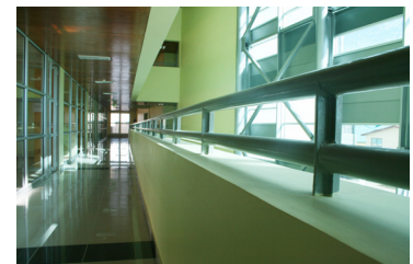
Figura 8.92. Vista interior Pasillo
