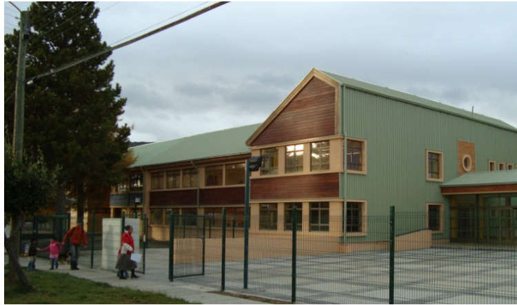
Figura 8.139. Vista acceso sur
