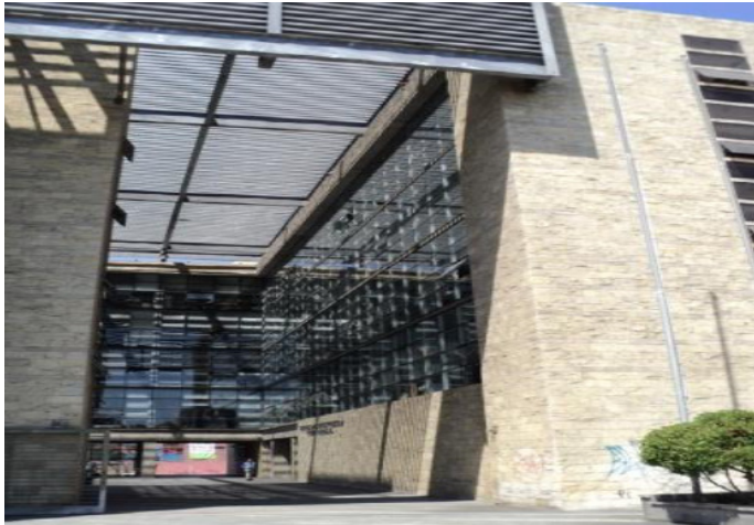
Figura 8.51. Protección solar horizontal
