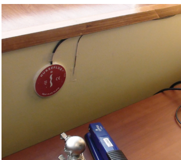
Figura 12. Mediciones de flujo de calor en muro de envolvente perimetral. Edificio PDI, Puerto Montt.
