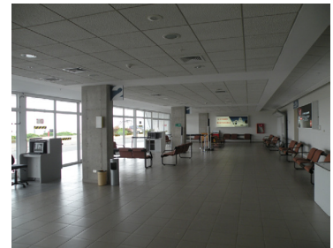
Figura 6.36. Acondicionamiento acústico en áreas comunes. Pasillo con presencia de material absorbente en el cielo.
