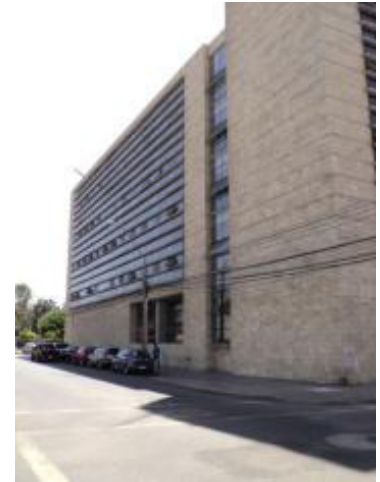
Figura 8.35. Edificio Secretaría Ministerial de Obras Públicas, Región de Antofagasta. Fachada Sur
