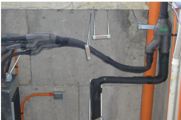
Figura 7.50. Branch derivador de flujo.
