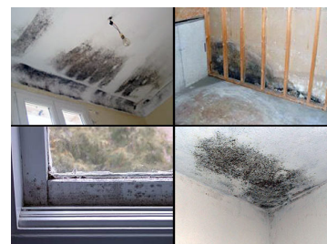
Figura 2.31. Efectos indeseados típicos de puentes térmicos.
