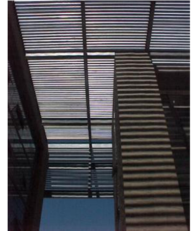
Figura 8.53. Vista interior protección solar horizontal
