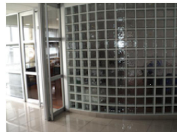
Figura 5.44. Tabiques translúcidos, Edificio Secretaría Regional Ministerial de Obras Públicas Antofagasta.
