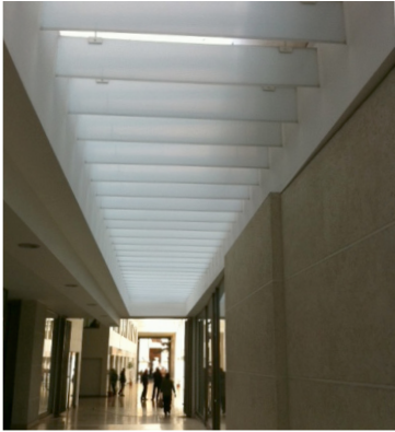
Figura 5.55. Dispositivos de protección solar interior en corredor de luz, Galería Comercial, Santiago.
