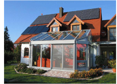
Figura 7.10. Instalación solar agua caliente y paneles fotovoltaicos.
