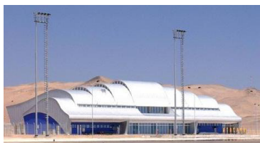
Figura 8.10. Vista exterior norponiente
