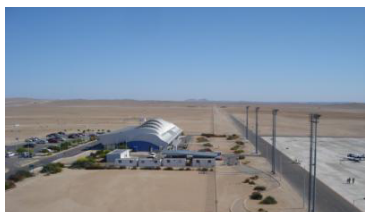
Figura 8.9. Vista exterior general
