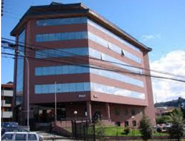
Figura 5. Edificio Secretaría Regional Ministerial de Obras Públicas, Puerto Montt, Región de Los Lagos. Sin EE.
