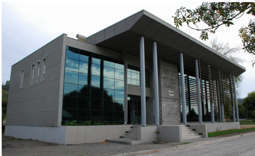
Figura 3.13. Muro Trombe CITEC UBB, Concepción (zona 6SL)
