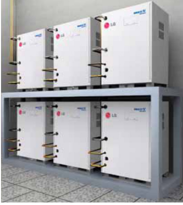
Figura 7.47. Unidades exteriores operadas con agua
