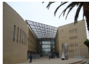
Figura 3.19. Muros con masa térmica en edificio MOP de Copiapó (zona 3 NVT)
