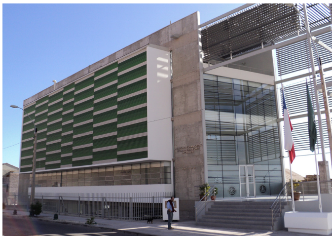
Figura 4.18. Edificio Labocar de Antofagasta (zona 1 NL). Protecciones solares controlan la radiación solar sobre muros de hormigón armado
