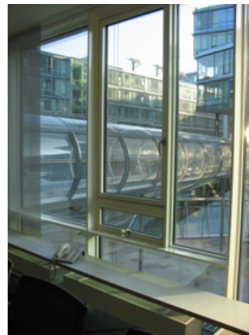
Figura 3.20. Ventanas proyectantes pequeñas para ventilación nocturna, edificio NORD/LB Hannover (Behnisch Architekten)
