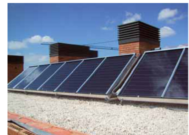
Figura 7.30. Instalación solar integrada a un edificio.
