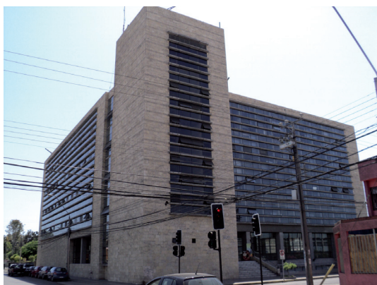
Figura 1.20. Fachada sur edificio de la Secretaría Regional Ministerial de Obras Públicas, Antofagasta, región de Antofagasta.
