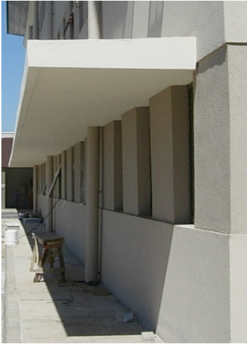
Figura 5.46. Alero horizontal, Contraloría de Temuco.
