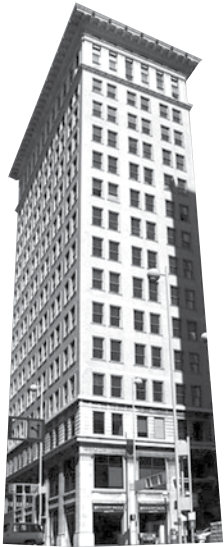
1903: Elzner & Anderson, edificio Ingalls, Cincinnati (Ohio), Estados Unidos. Primer rascacielos de hormigón armado.
