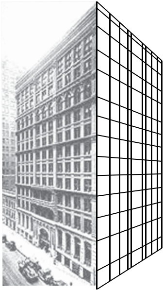
1884: William Le Baron Jenney, edificio de la Home Insurance, Chicago, Estados Unidos. Este entramado de acero y fundición de diez plantas de altura soporta la mayor parte del peso de los forjados y los muros exteriores.
