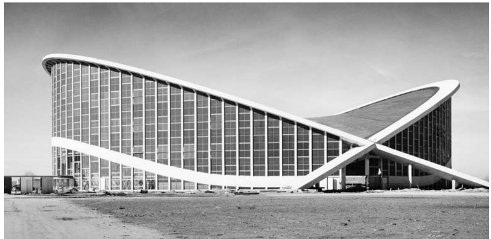
X-12. Estadio de Raleigh. Arquitecto Henley Deitrick. Ingeniero Matthew Nowicki. Ingenieros Asesores, Severud-Elstad-Krueger. Fotografía: Lewis P. Watson.
