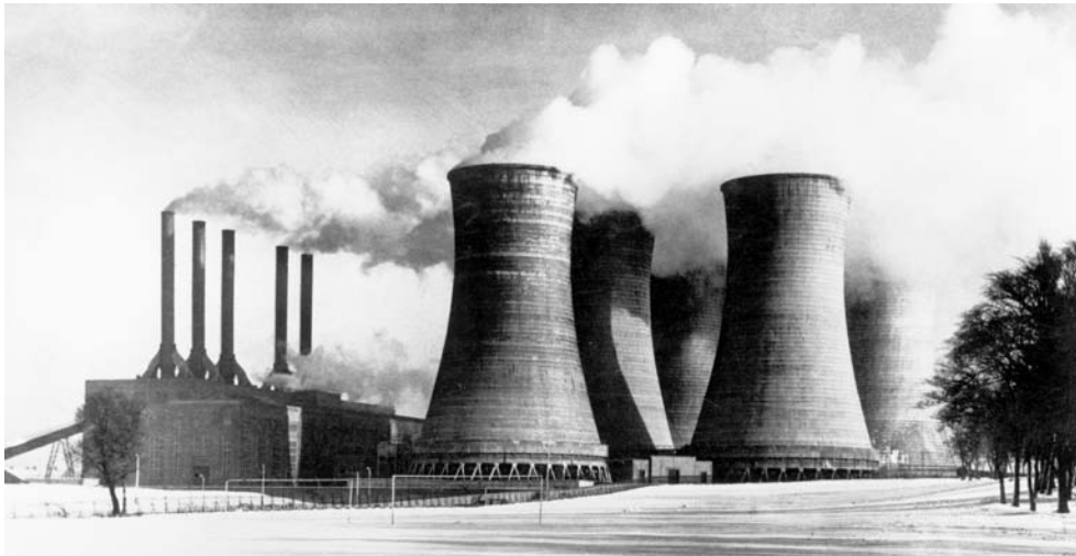
XV-1 Refrigeradores de la Wolsall Power Station, Staffs. Fotografía Craftsmen, Ltd.
