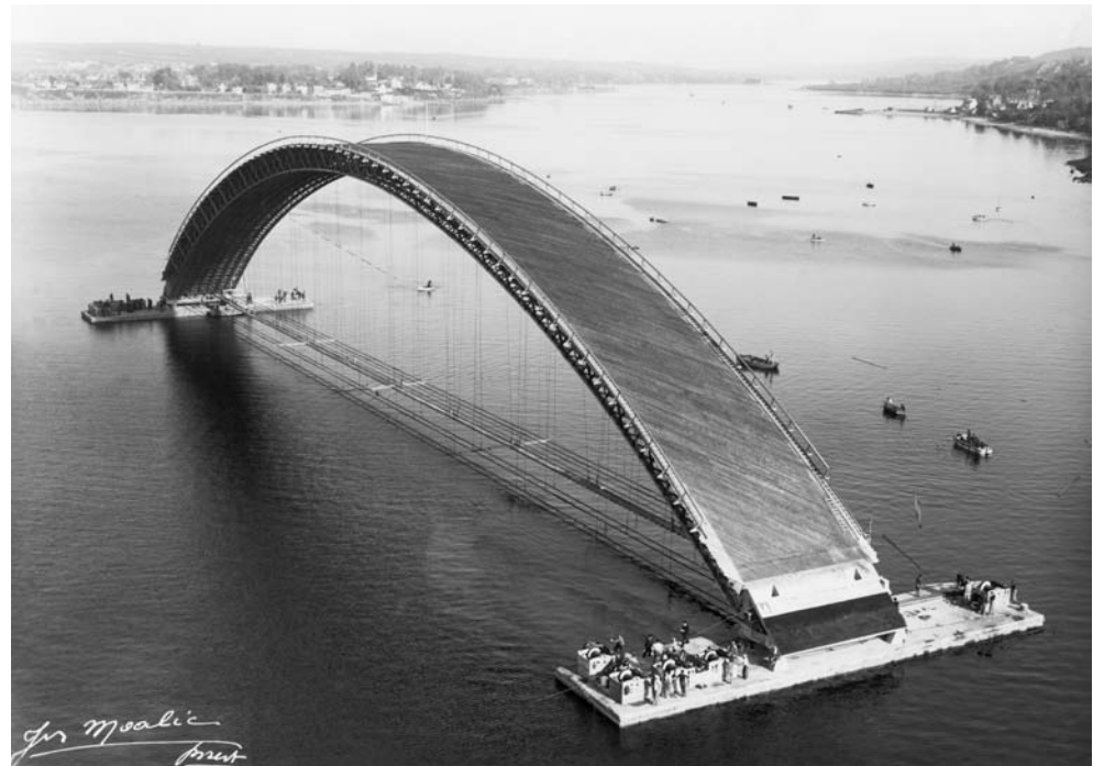
VII-6. Cimbra flotante para el puente de Plougastel. Ingeniero E. Freyssinet. Fotografía: J. Moalic.
