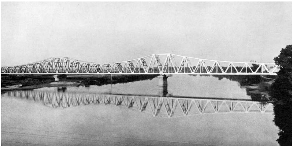
X-2. Puente de Moissac. De «Esth et Constr. des Ouvrages d'Art». J. Demaret.
